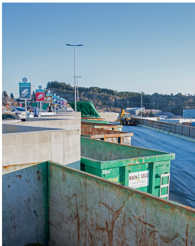
Containerne står på utsiden av området publikum har tilgang til, noe som bidrar til god sikkerhet.
