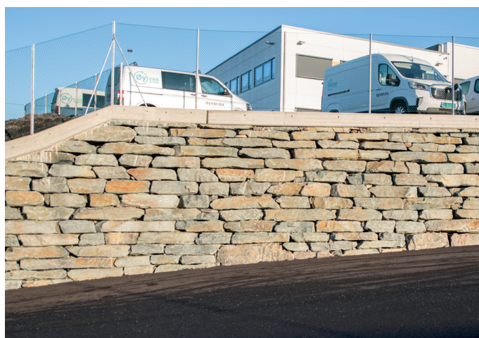
Natursteinsmur ved innkjøring til anlegget.
