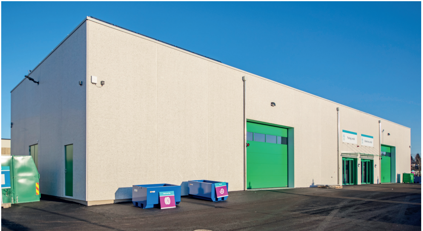
Bygg B inneholder mottak for farlig avfall og elektroavfall og teknisk rom for varmesentral.
